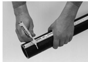
Обезжириваем поверхность прилегания фитинга к трубе.
