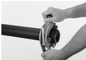
Снимаем оксидный слой с трубы (НЕ ИСПОЛЬЗОВАТЬ АБРАЗИВНЫЙ ИНСТРУМЕНТ).
