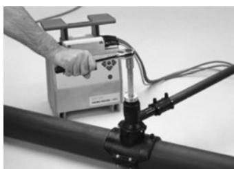
Прорежьте трубу с помощью специального шестигранного ключа через отверстие в верхней части седла.
