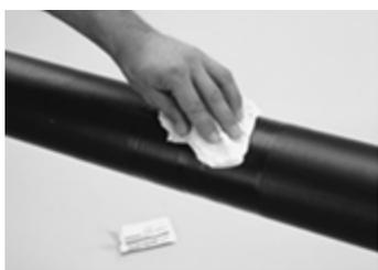
Снимите оксидный слой с трубы в месте прилегания. **(НЕ ИСПОЛЬЗОВАТЬ АБРАЗИВНЫЙ ИНСТРУМЕНТ)**
