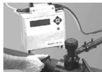
Установите наконечники электромuffтового аппарата на клеммы седла.
